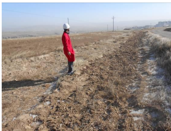
管线经过地段已恢复地貌
