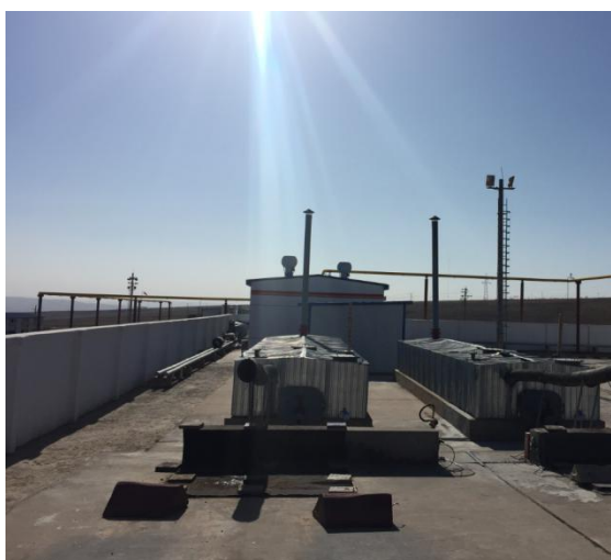
华二集输站卸油区
