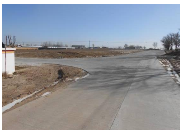
新基地进场道路硬化
