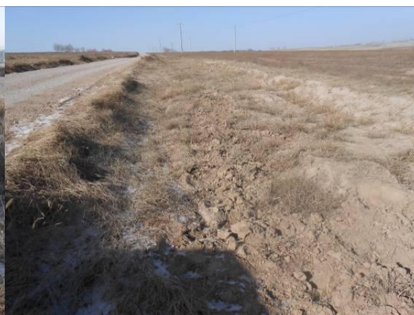
管线经过地段已恢复地貌
